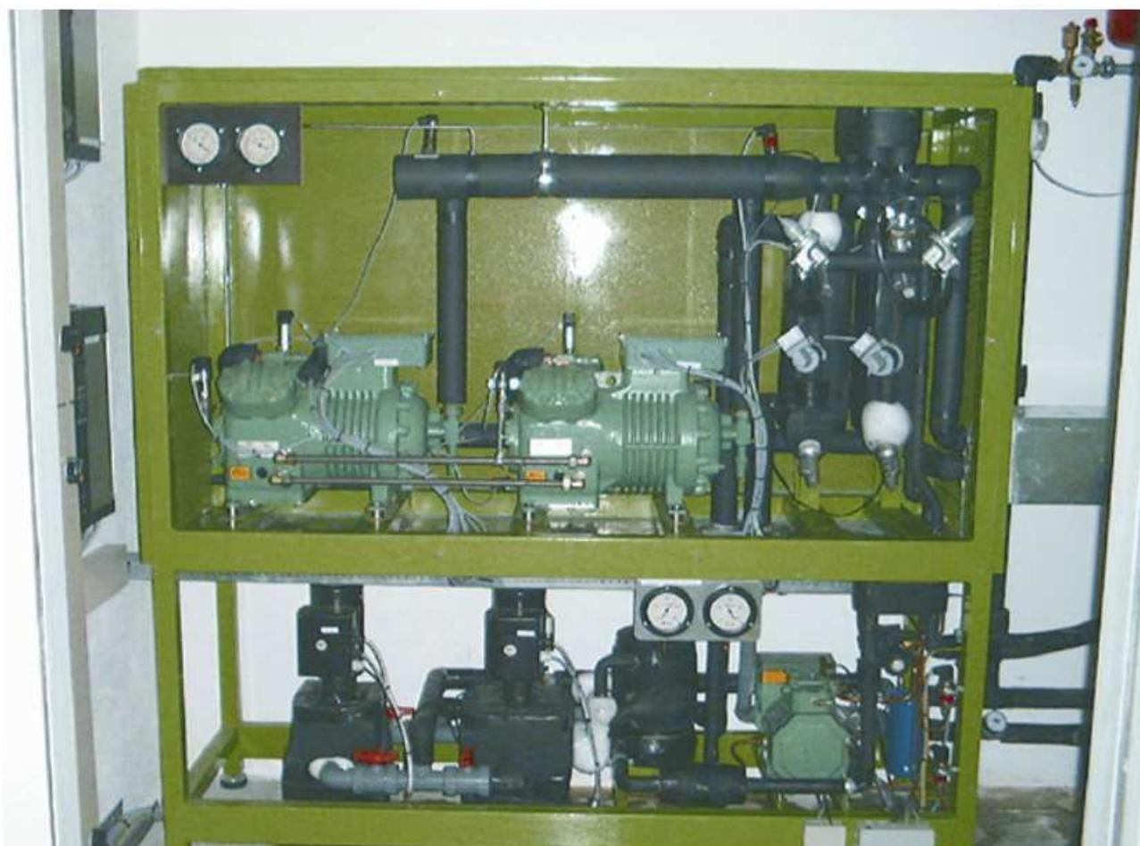
Рис. 2. Внешний вид каскадной холодильной установки.
